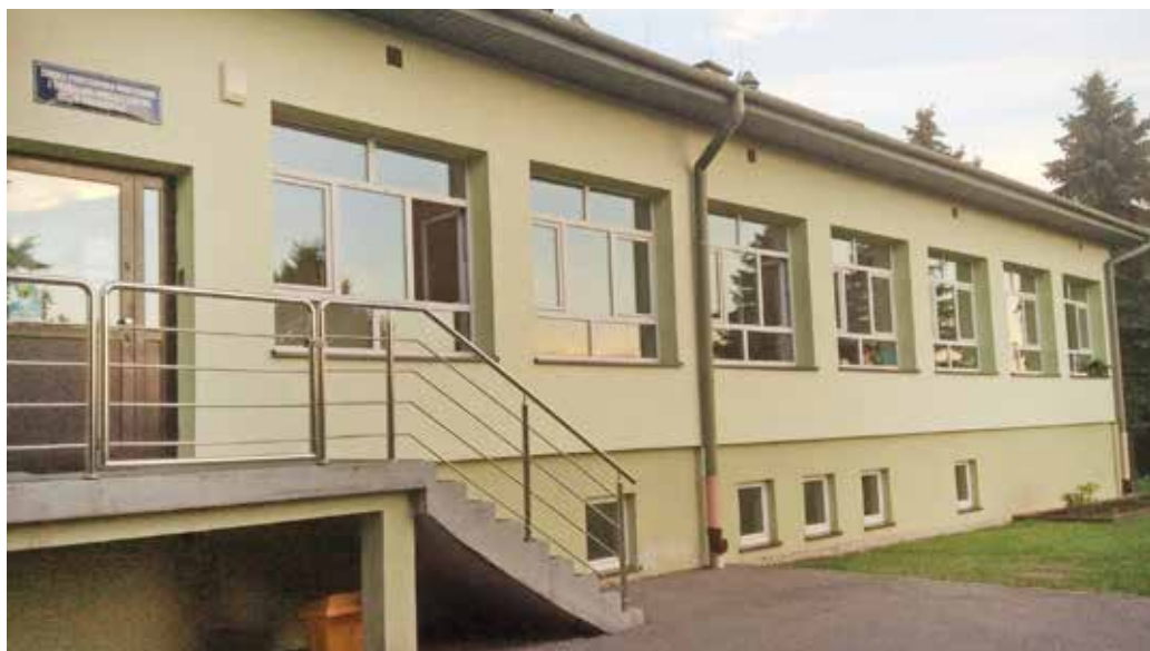
Fot. 4. Siedziba Szkoły Podstawowej Montessori z Oddziałami Dwujęzycznymi w Boguchwałe – fasada z wejściem głównym.
